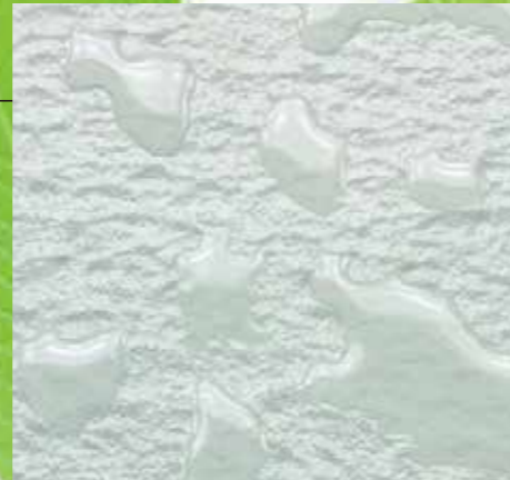
リボール式防水の塗膜表面
